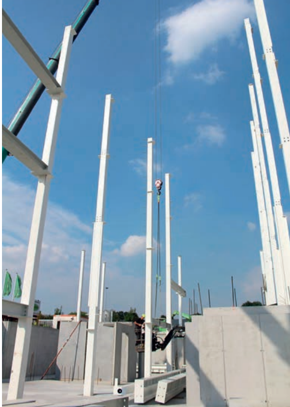
Aannemer Vulsteke Bedrijfsgebouwen overtuigde architect én bouwheer om het gebouw in een staalstructuur op te trekken. "Dit gaf het gebouw een slanker uiterlijk, reduceerde de uitvoeringstermijn én drukte de kostprijs met zo'n 10%"
